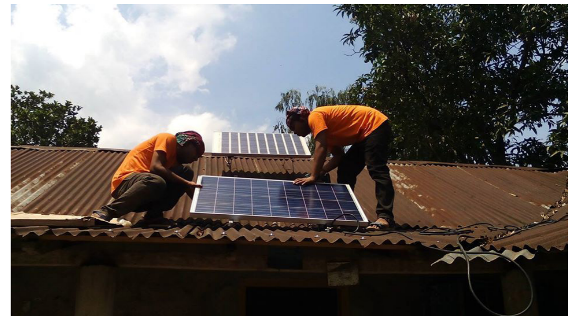
Hình 12: Lắp đặt pin năng lượng mặt trời ở nông thôn Bangladesh (Ảnh: me-solshare.com)
